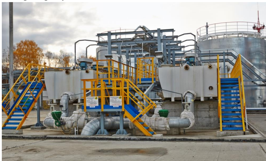
Рис. 3. Узел флотации
