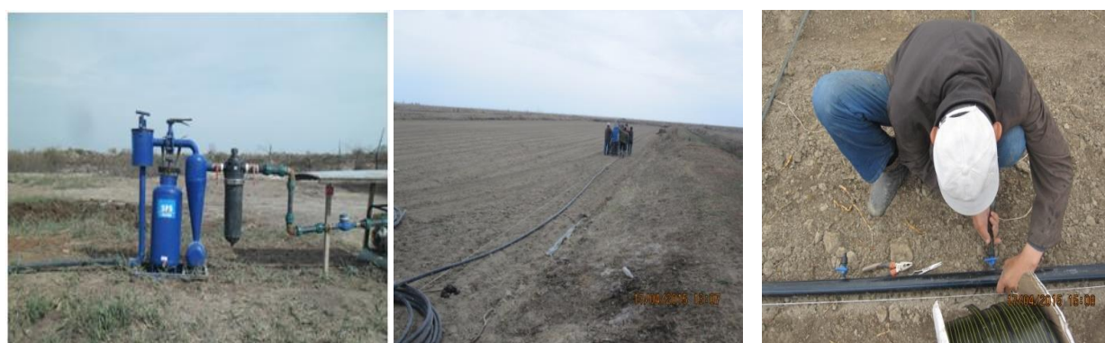
Рис. 2. Наладка капельной системы орошения на экспериментальном участке
