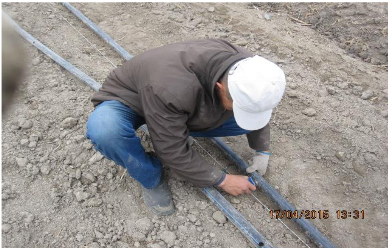
Рис. 2. Гибкие водопроводы LayFlat и капельные линии Metzeplas, Израиль
