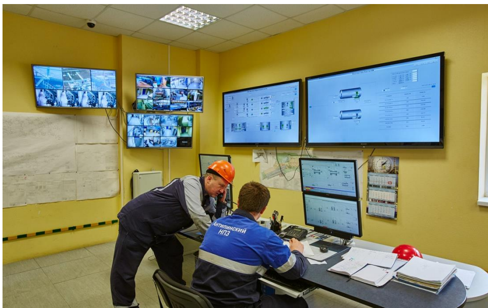
Рис. 1. Операторная очистных сооружений
