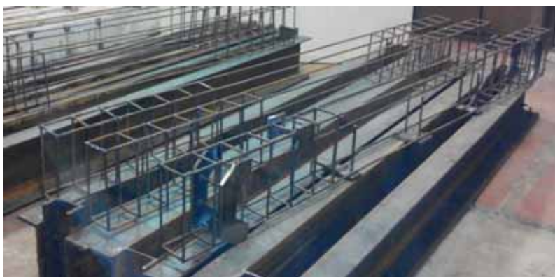
Рис. 1. Загальний вигляд арматурних карасів із закладними деталями
