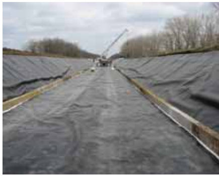
Рис. 4. Привантаження протифільтраційного екрану Рис. 5. Відновлена ділянка каналу
