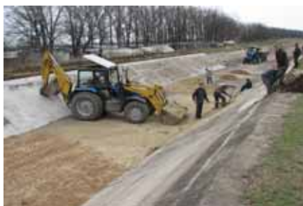
Рис. 2. Підготовка основи каналу
