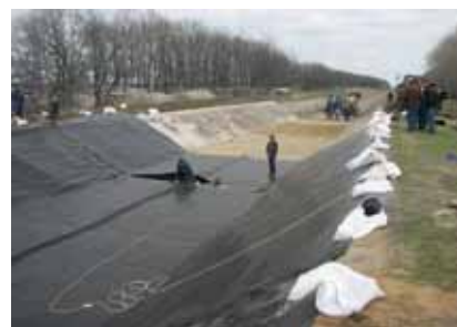
Рис. 3. Вкладання та зварювання геомембрани
