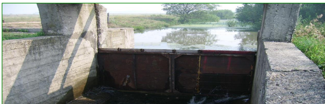
Фото 1. Шлюз-регулятор мелиоративной системы «Тинки – II», ОПХ «Полково»
