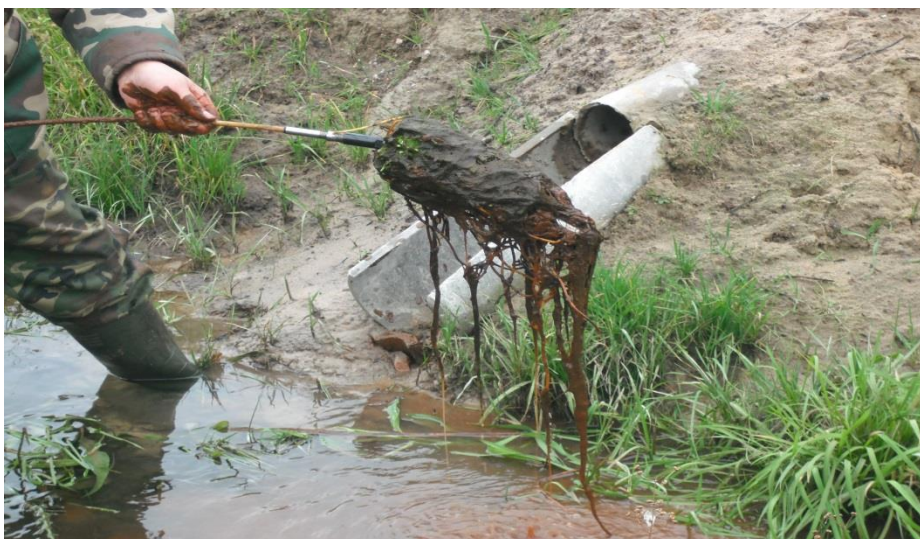
Рисунок 2. Очистка коллектора от корней растений корневой насадкой МК-1.
